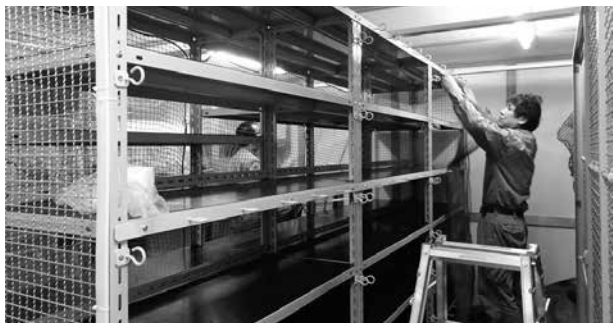
収蔵庫棚耐震化工事 第3収蔵庫
