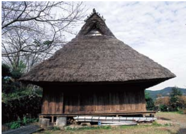
味元家住宅。厚く葺かれたカヤ屋根が夏の日射しを遮断する
