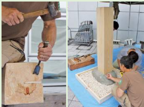
礎石の凹凸にあわせて柱の底面を削り、立てる
